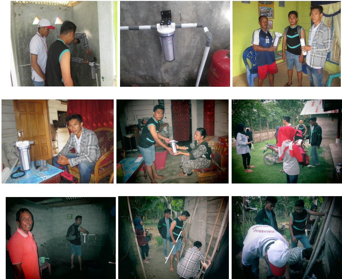
Gambar 1. Rangkaian kegiatan Pemasangan Instalasi nano filter.
