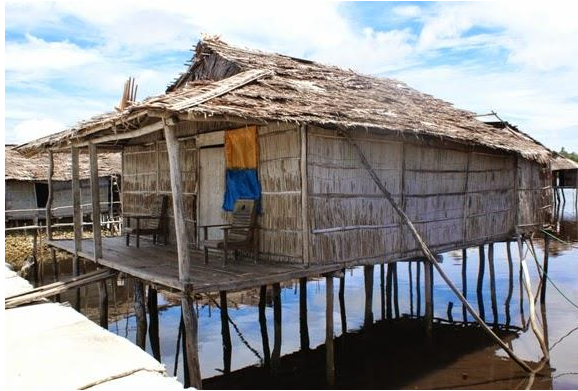
Gambar 4: salah satu rumah Suku Bajo di Desa Torosiaje Laut yang masih mempertahankan material tradisional, dengan atap rumbia, dinding bambu yang di pecah, dan kolom tiang kayu bulat.
