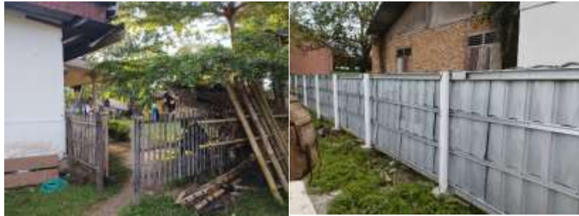
Gambar 4. Kondisi Pagar Atau Pembatas (Sumber : Analisa Penulis, 2026)
