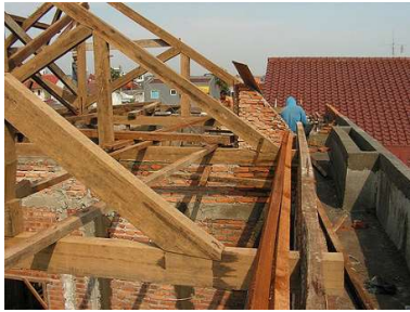
Gambar 14 Rangka atap kayu
