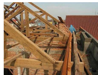
Gambar 9 Rangka atap kayu
