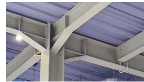
Gambar 18. Kolom dan balok material baja
