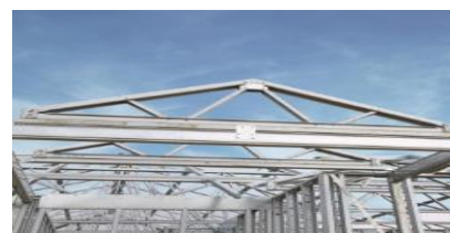
Gambar 15 Atap Rangka Baja/Baja ringan Sumber : Analisa Penulis, 2022
